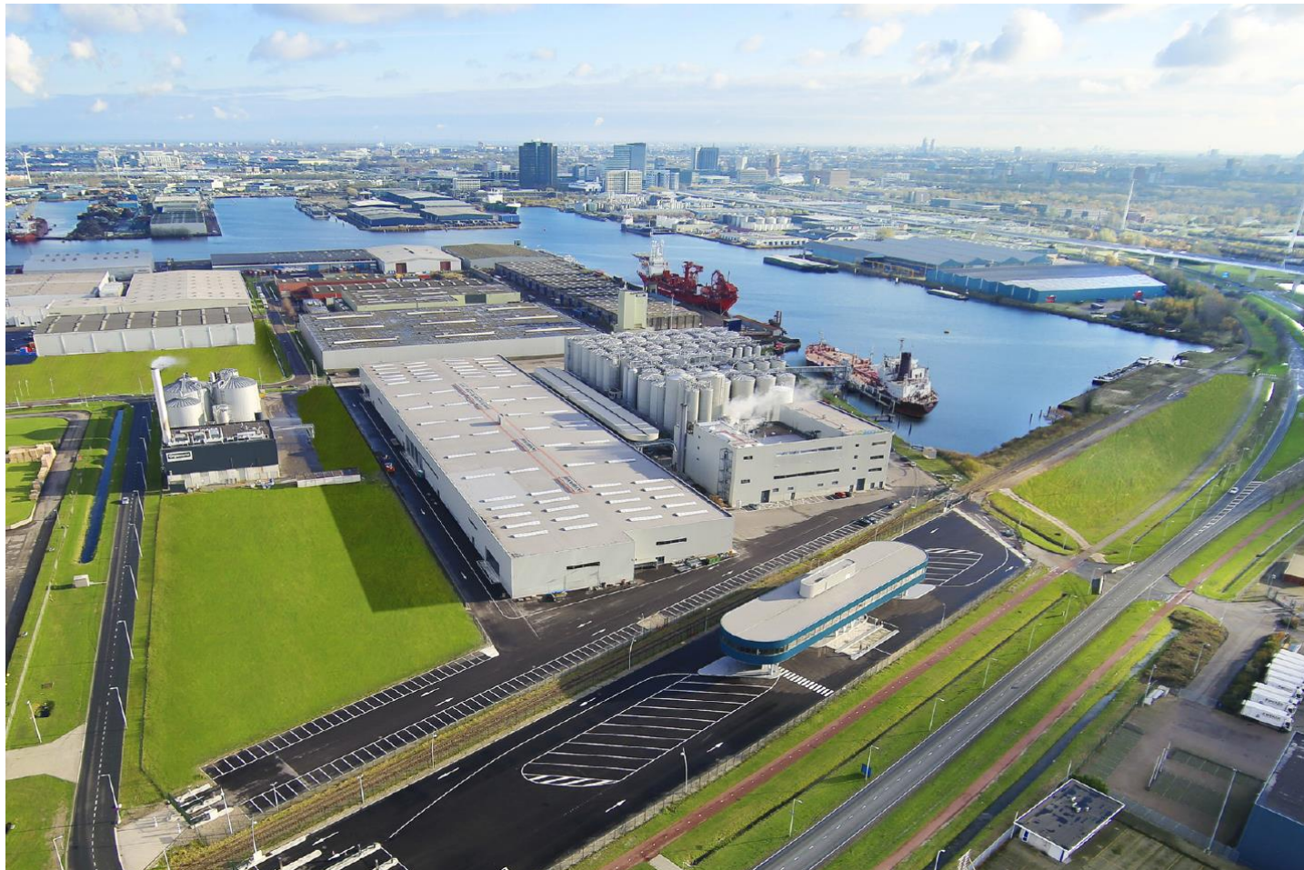
Luchtfoto van het terrein van Argent Energy. (Foto Argent Energy)
